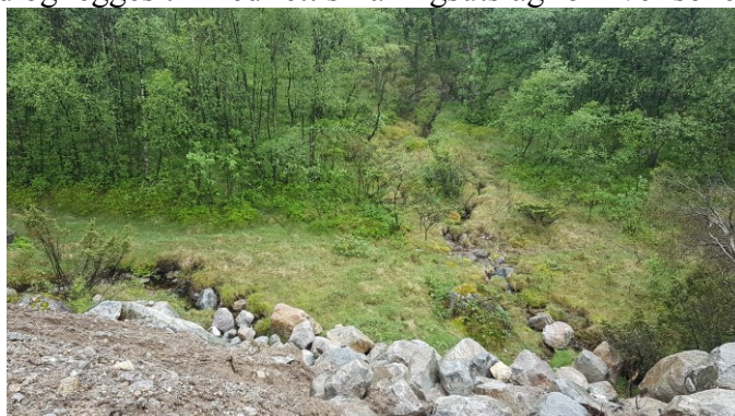
Bekk på sørsiden, ferdig terreng av sluttet noe høyere en bekken.
