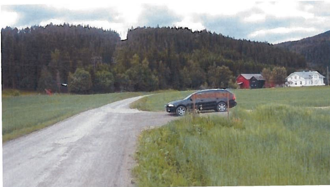
Figur 8: Avkjørsel fra kommunal veg og inn til uttaket. Skilt i frisiktsone skygger for sikten ved utkjøring.
