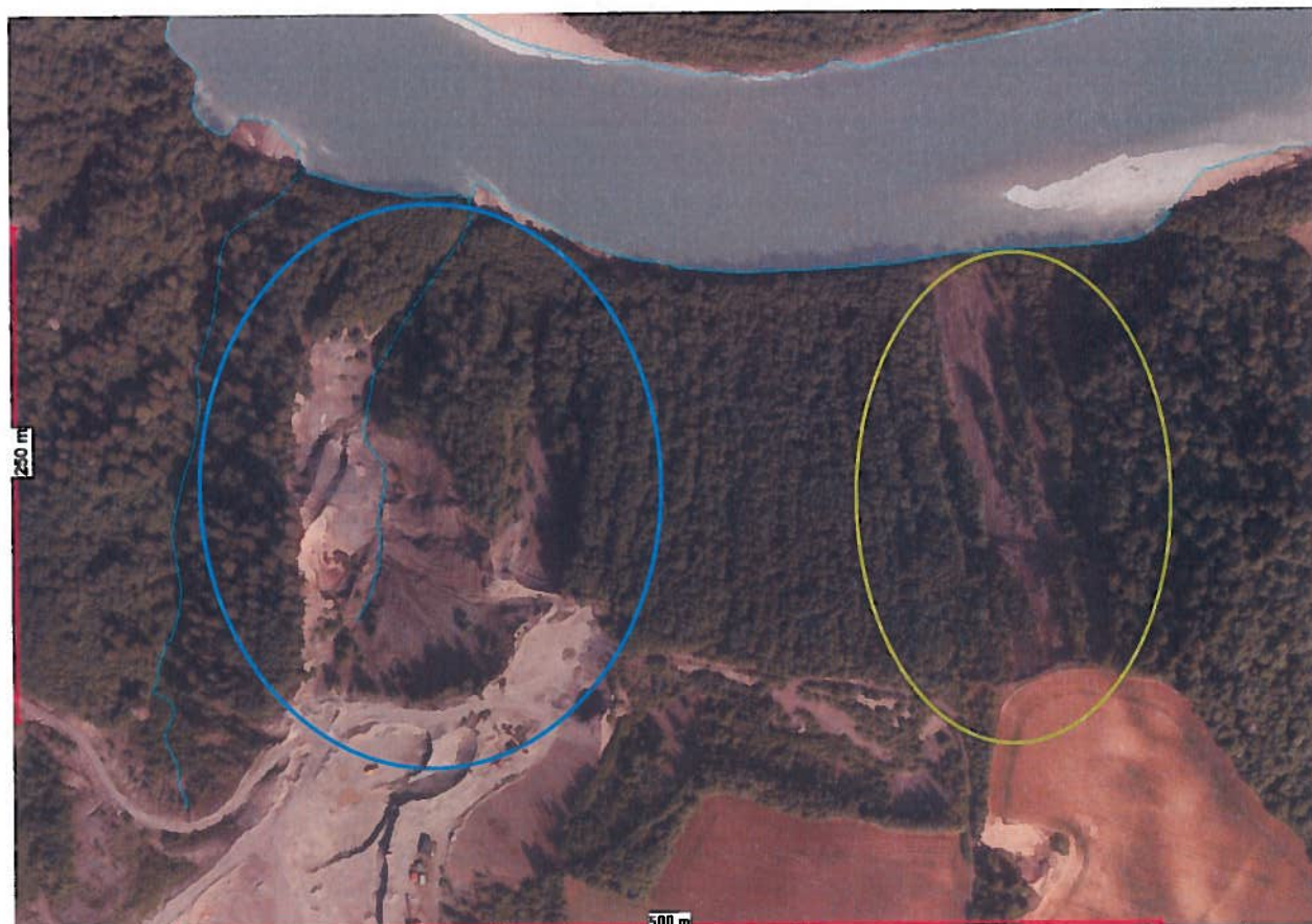
Ortofoto fra 2011 som viser de to ravedannelsene (blått) og omfattende erosjon (grønt).
