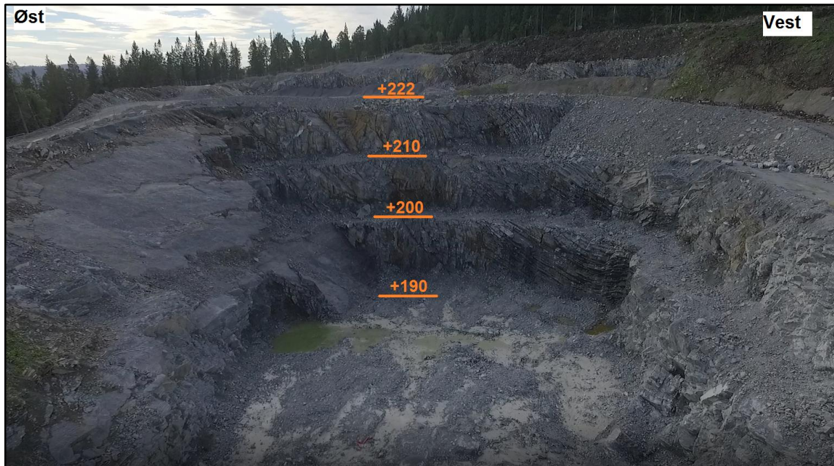
Figur 1 Sørenden av bruddet. Sprekkeretning sees tydelig i sørveggen
