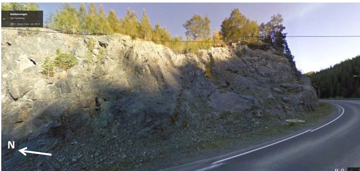
Bildet viser deler av skjæringen sett mot SØ (kilde: Google Streetview)
