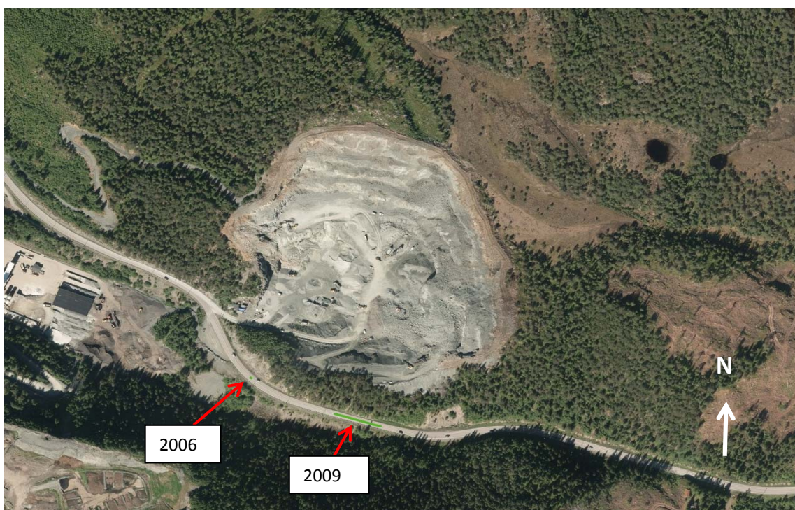
Flyfotoet viser områder for registrert nedfall av stein på fylkesvegen (kilde: Vegkart fra SVV)
