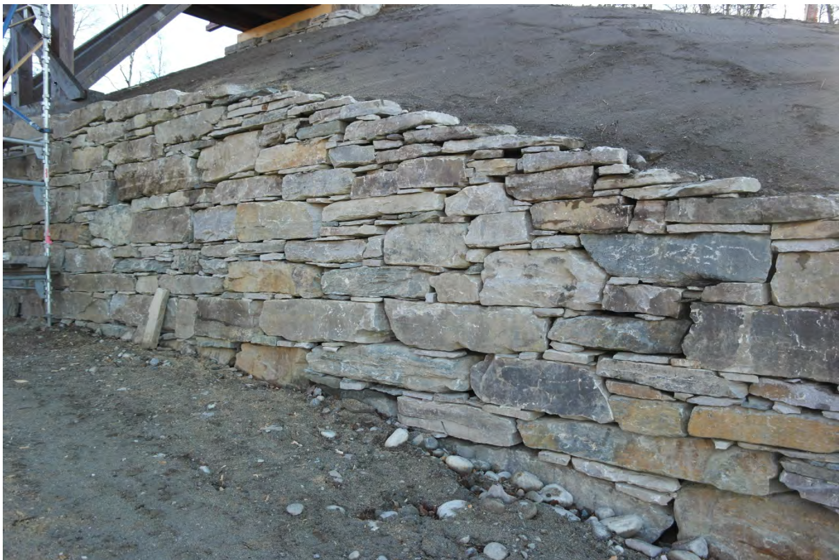
Figur 3 Murestein fra Siksjølia brukt i skianlegg på Røros
