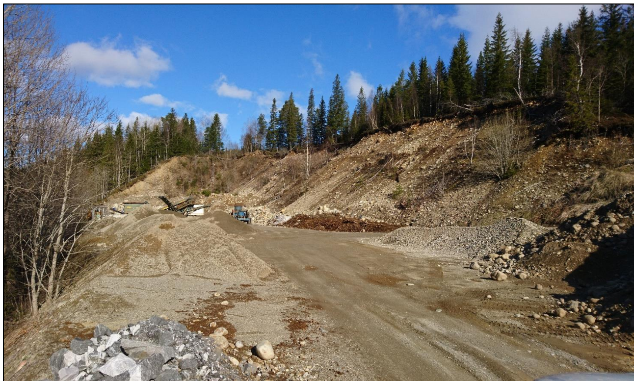
Figur 2 Bilde tatt mot vest. Stufen til høyre i bilde er avsluttet. Her pågår tildekking med jordmasser.
