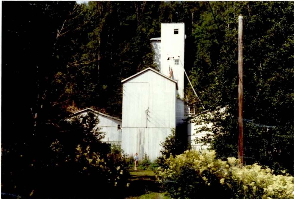
SUNNAN KALKBRUDD 1980. Bilde av knuse-mølleanlegg og silo.
