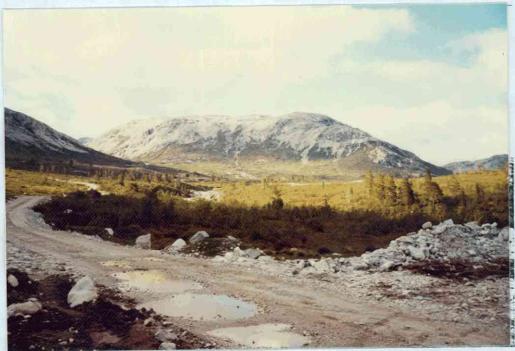
Anleggsveien i Rjoanddalen. Grodgjuvet ligger i bakgrunnen til venstre. Såtebu-feltet ligger bak i høyre kant av fotoet.
