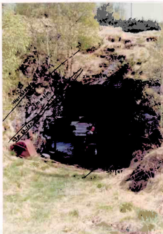
Foto 3 Nedre Kleven stollingang (bilag 29). Sikt mot øst. Denne transportstollen er 430 m lang. Malmen er utstrosset i en ca 80m x 160 m stor flate ved profil 900 - 1000 (bilag 33 og 34). Magnetittmalmen i stoll-åpningen er 3-4m mektig.
