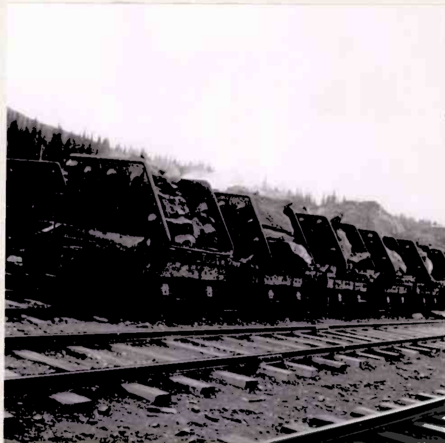
Abbildung 10: Erzwagen für 10 t zum Transport von der Grube zum Grobbrecher
