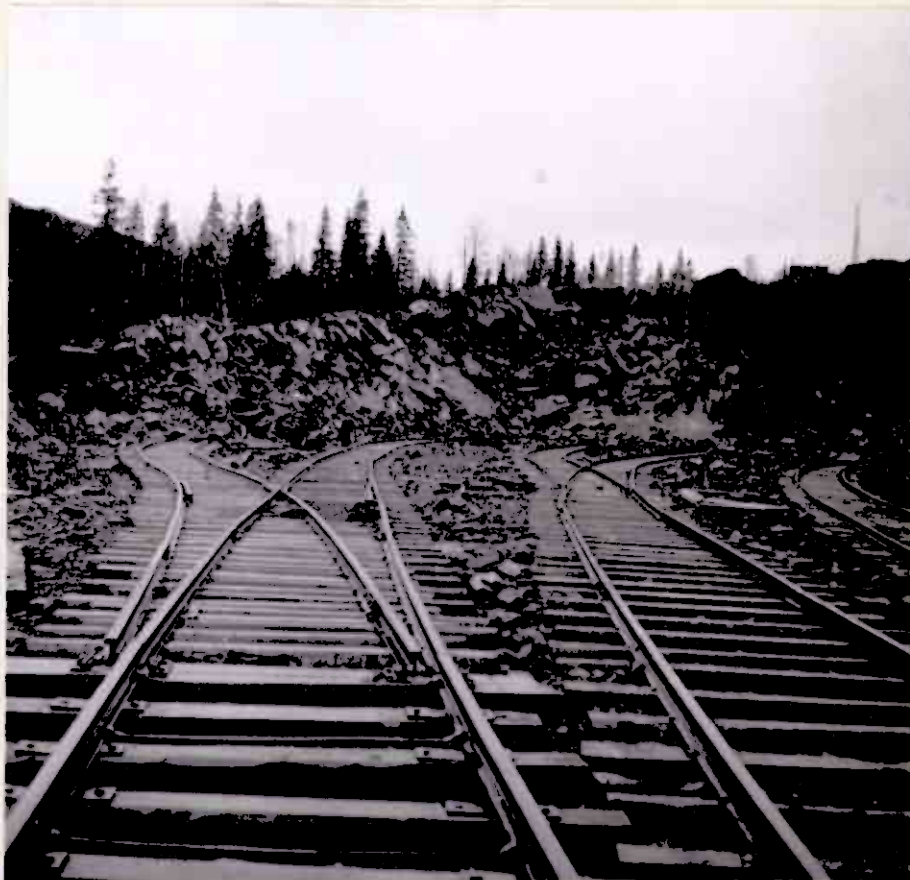
Abbildung 6: Obere Sohle eines Tagebaues in Storforsheien Die für den Dampfschaufelbetrieb erforderlichen umfangreichen Gleisanlagen.
