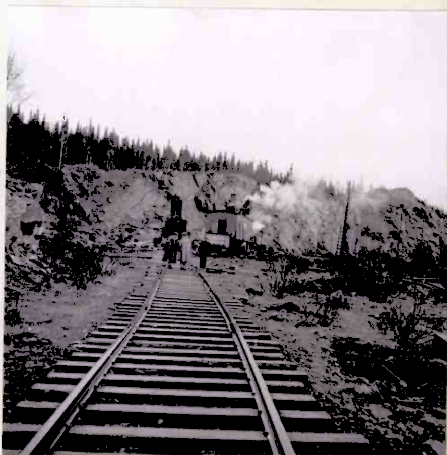
Abbildung 6: Obere Sohle eines Tagebaues in Storforsheien Die für den Dampfschaufelbetrieb erforderlichen umfangreichen Gleisanlagen.
