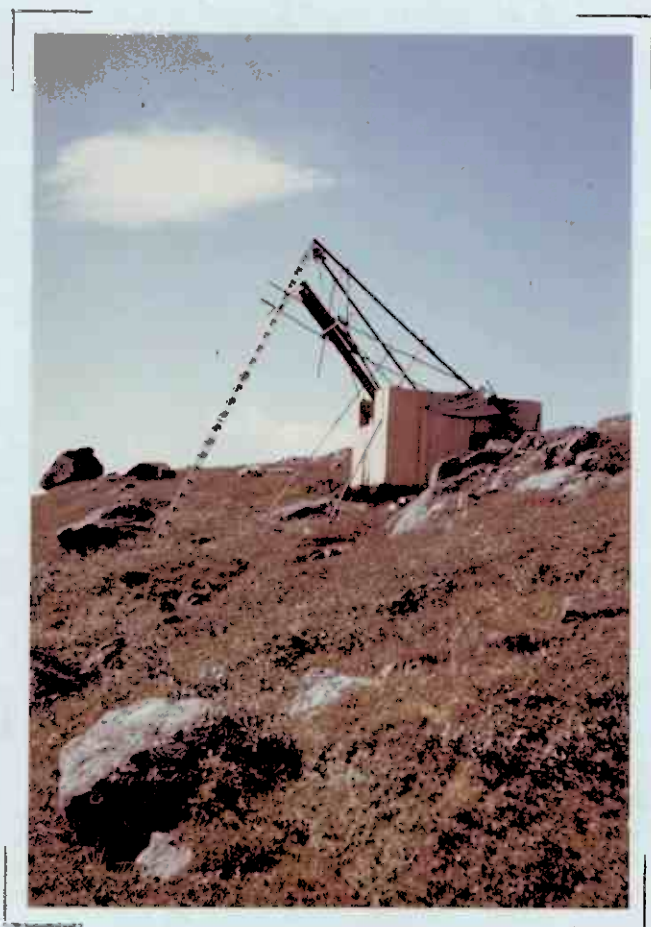
Fra diamantboringen. Maskinen står i profil 10250Y og borer C-hullet.
