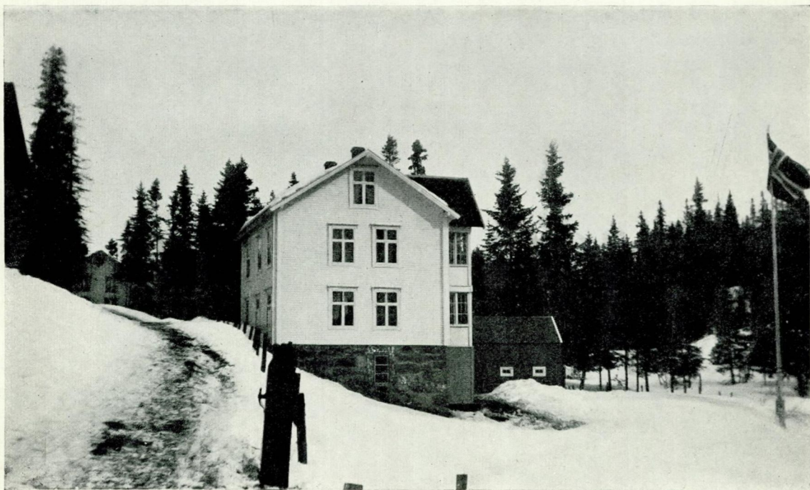
Villa «Skogheim» ved Reitan.
