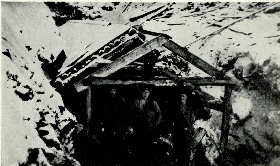
Reparation av stoll=indgangen.
