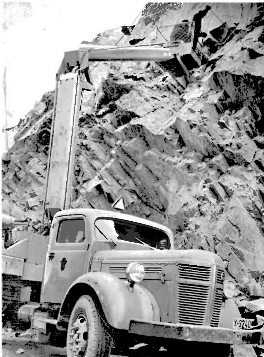
Hydraulisk regulert plattform brukes ved rensingen av veggene i dagbruddet Bjørnevatn.
