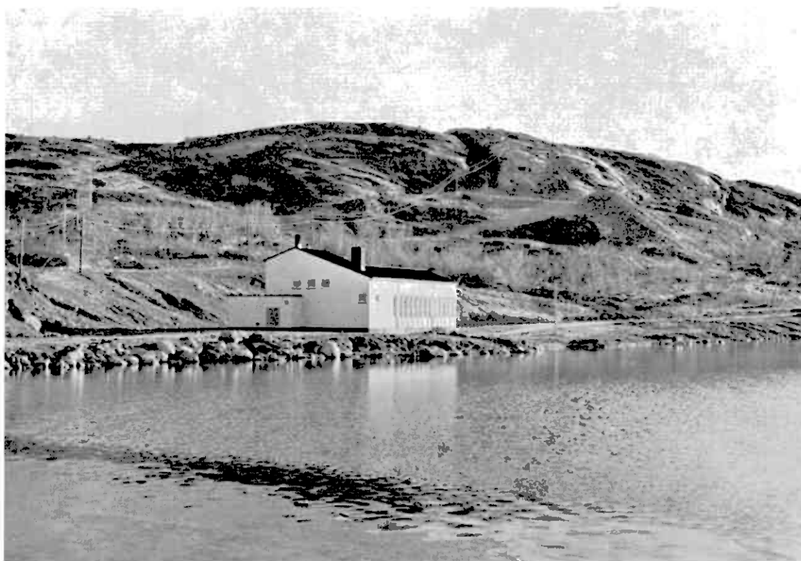
Det nye pumpehus for vannforsyningsanlegget Kirkenes.
