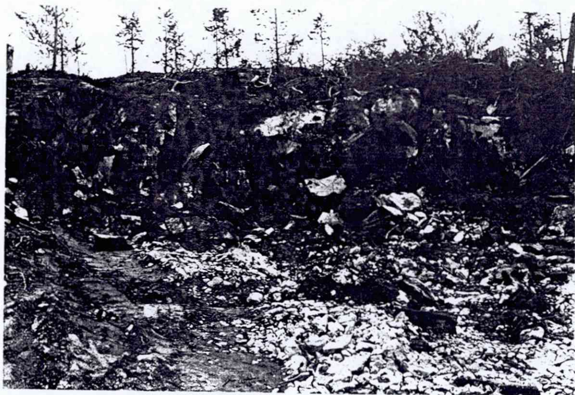
Objekt 2. Etter skyting. Malmen er oppsprukket og dypforvitret langs klorittsonen.
