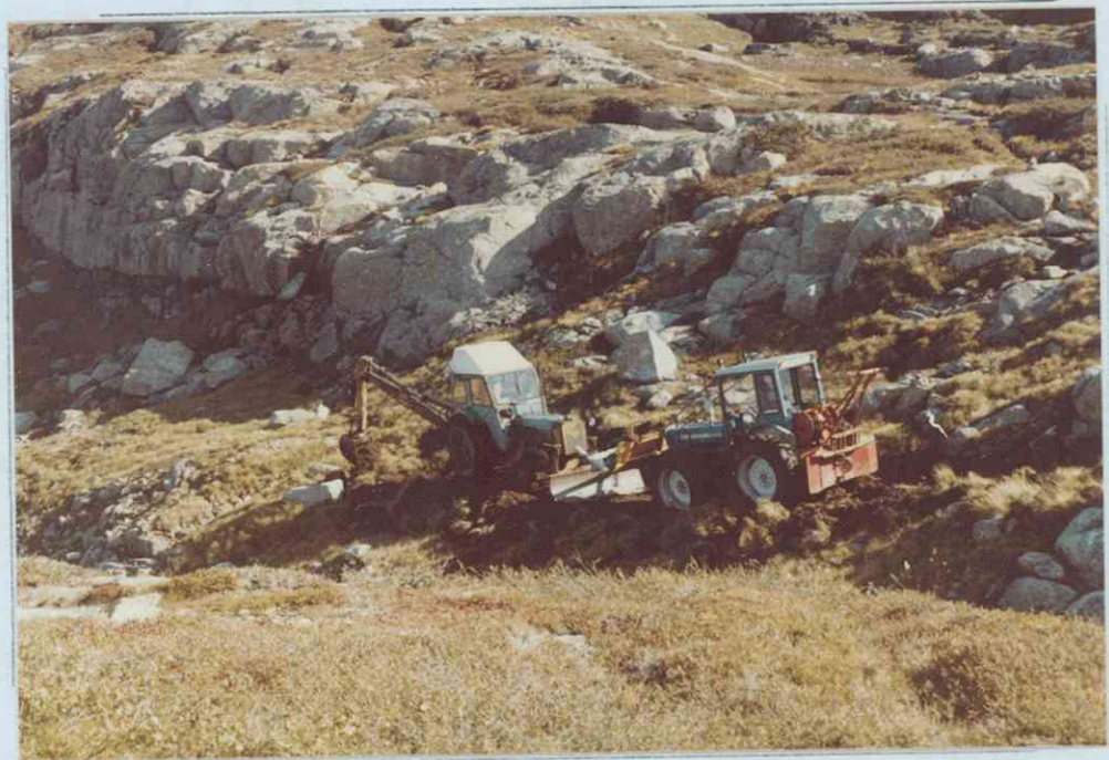
Digging road to DH 5-84.
