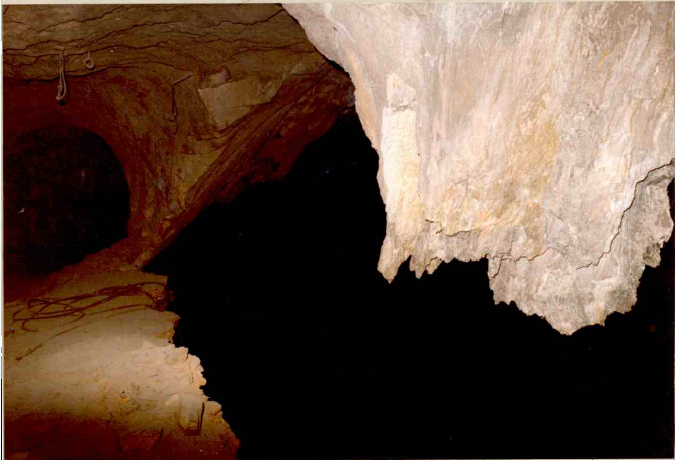
NIVA 6 - VEST. Nedrast pilar i vestenden av strosse nr. 1 etter neokaledonsk forkastningszone ca. den 26. 04. 1987 Utsikt mot nord ca. fra X+5 og Y+313. Etter ras ca. den 26. 04. 1987. Tverrfillet 07. 05. 87.
