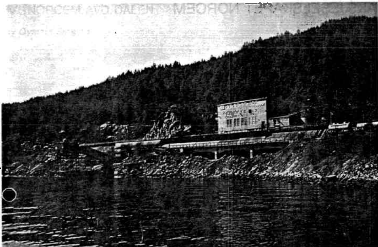
Hovedkontoret i Trondheim fra sjøsiden. Under kontoret er flotasjonsverk, siloanlegg og utskibningsanlegg.
