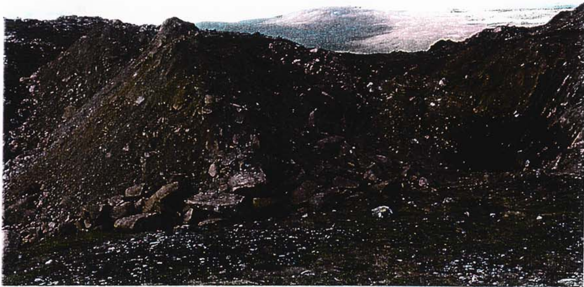
Røskearbeid igang. Digging
