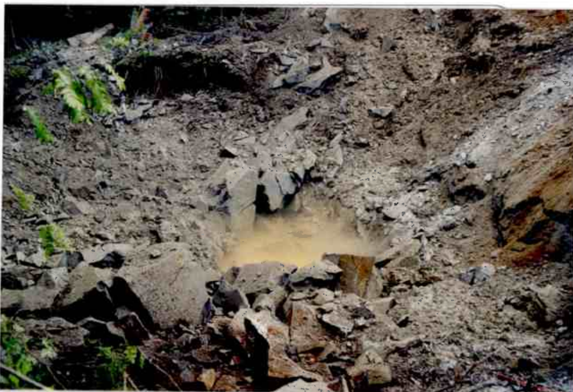
120 kg dynamitt senere - 60 m 3 fjell brutt (sett mot vest).
