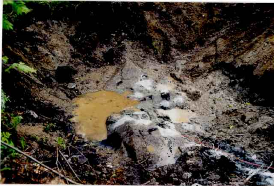
18 hull boret og ladet - Klar for sprengning (sett mot vest).
