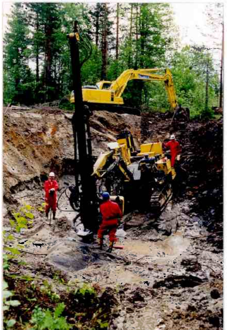
Klargjøring før boring. Spyling av fjell (sett mot øst).
