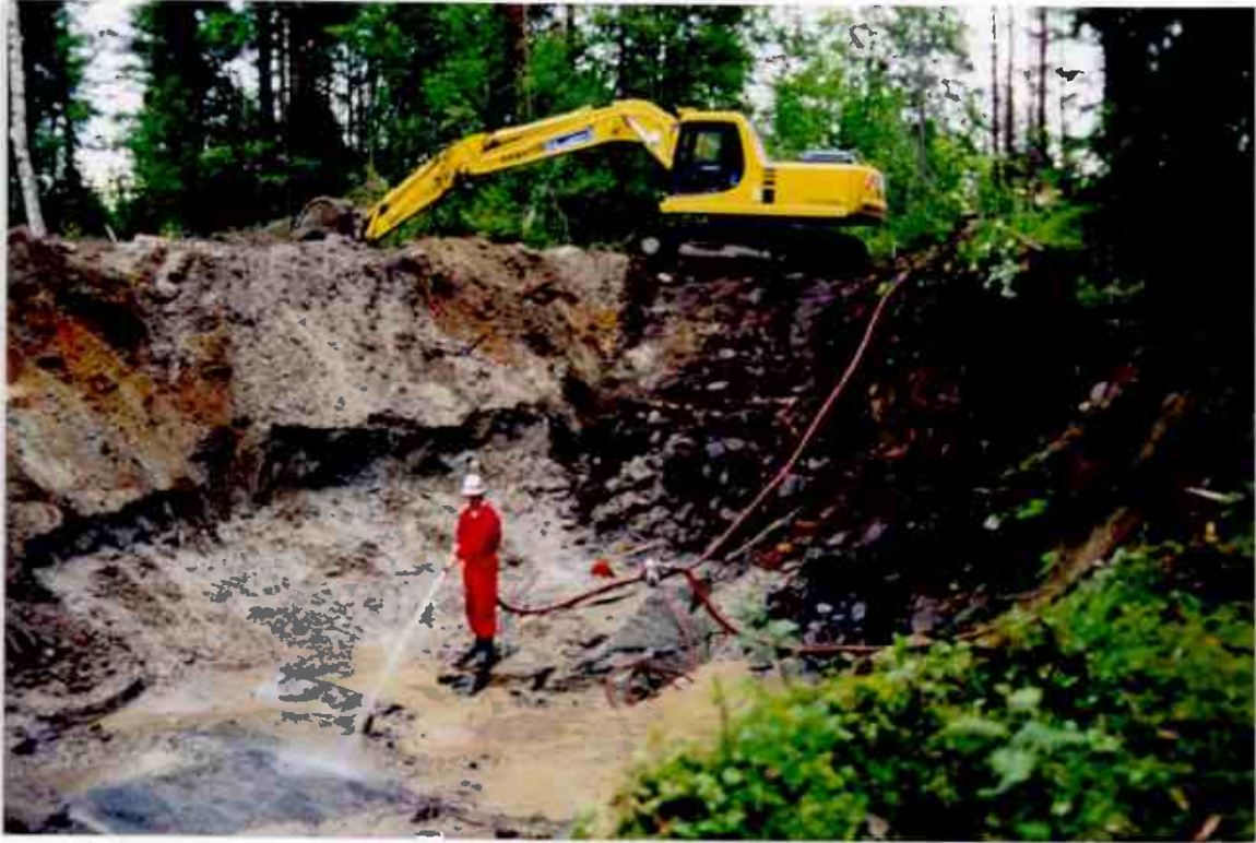
Klargjøring før boring. Spyling av fjell (sett mot øst).
