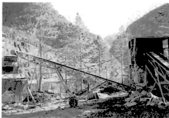
Kjefttygger m. overbygg. Band til dobbeltdekket sikt. (Foto: O.Ødegaard 1972.)
