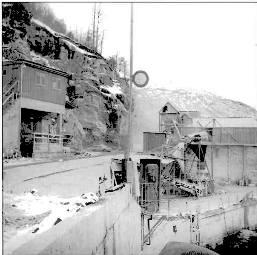
Kontorbygg og knuseanlegg på begge sider av vegen.
