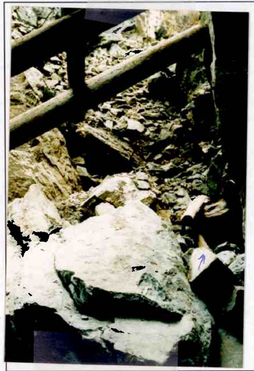
Bildet er tatt oppover. Pilen viser åpningen til gangen bak. De nye tverrstøttene er plassert samme sted hvor de gamle sto.
