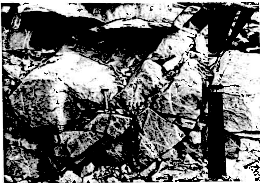
Fig.168a Grov oppsprekking i den tektonisk övre del av metadioritt v/Nordnes. Sprekkeplanene er parallell den mylonittiske planstruktur i de undre deler.
