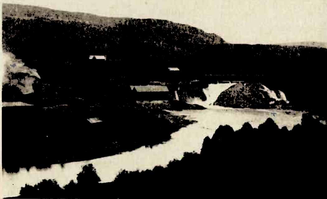
Nustadfoss 1900. Teglverk til venstre, sliperiet til høyre.
