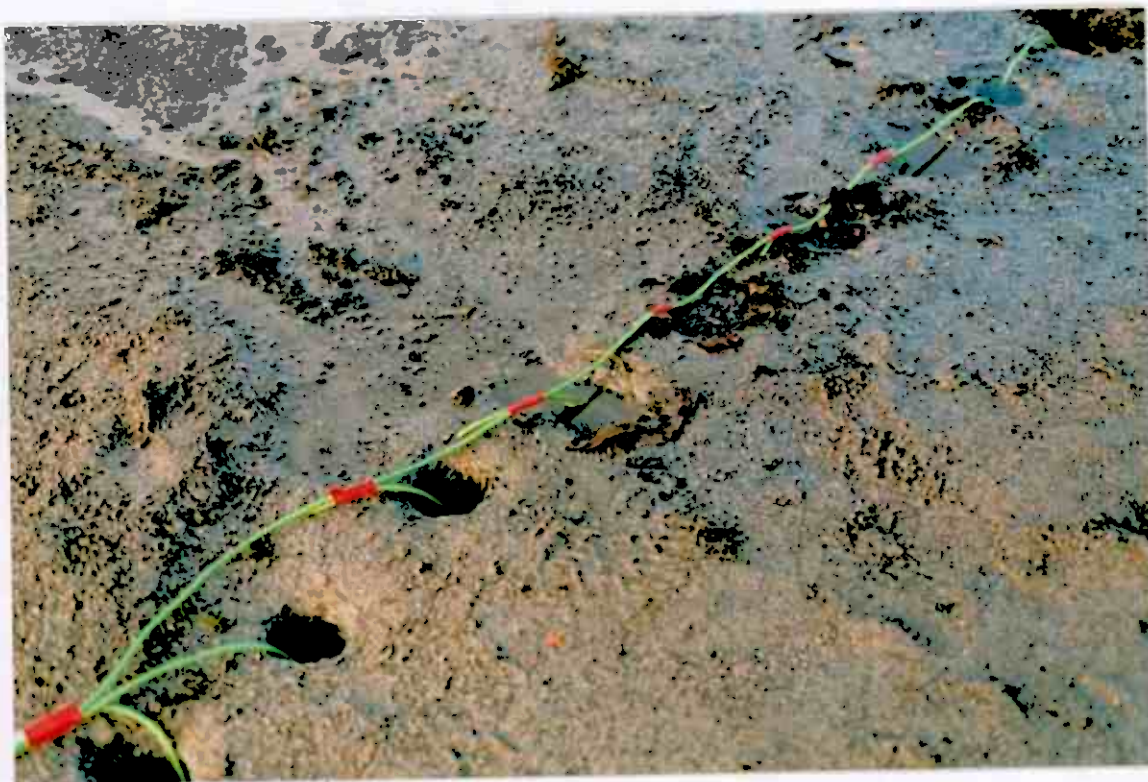
Fig. 7: Oppdeling ble utført med detonerende lunte og vann i borhullet.
