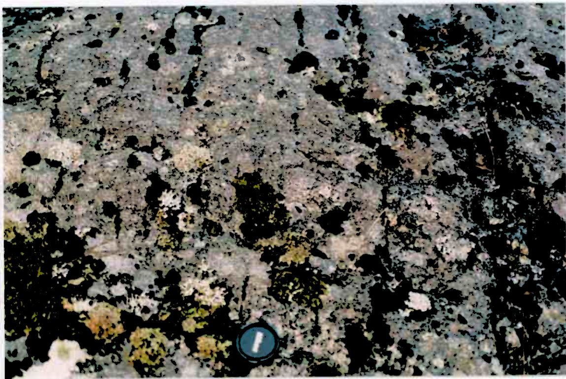
Fig. 14: Grodde sprekker i forvitret overflate.
