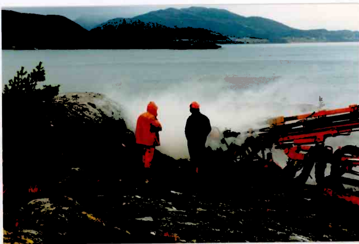
Fig. 5: Boring av liggere. Merk den uheldige vinkelen på borstangen.
