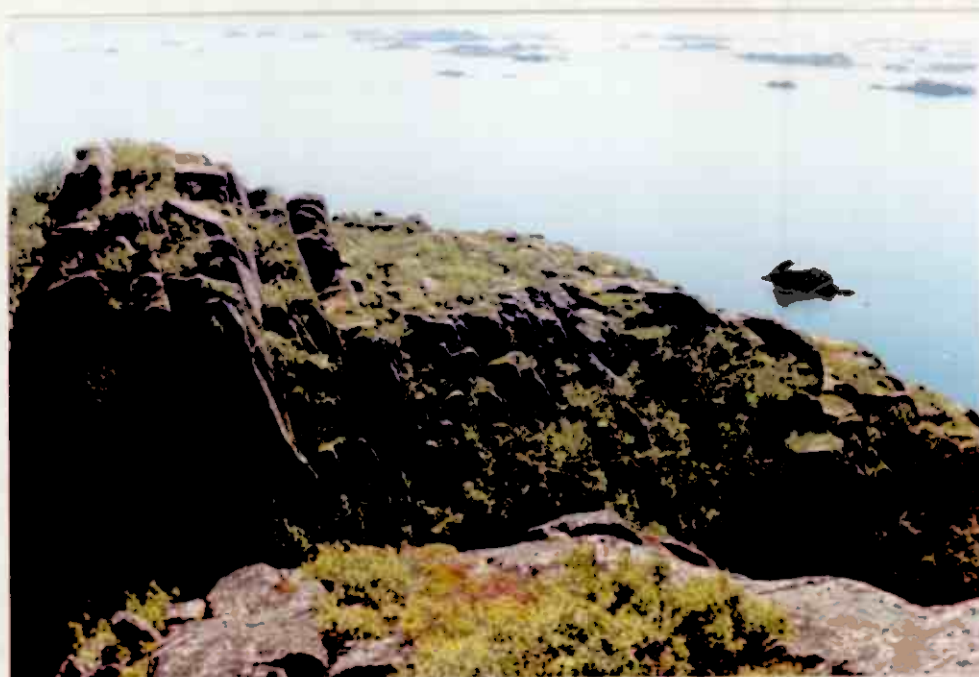
Fig. 3-11. Bildet viser oppsprekning i fjellet syd for kløfta.
