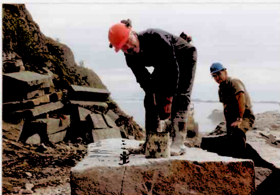
Fig. 3-5. Bilde som viser hvordan kilingen blir utført. Hullavstand i kilsøm 10-20 cm. (T.v. R. Nilsen, t.h. F.M. Vokes)
