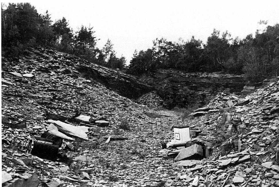
Fig.1. Hovedbruddet ved Espeland (sett mot NV).
