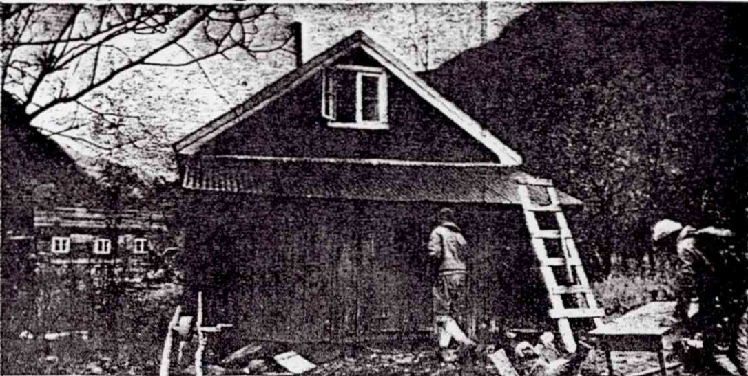
Mens arbeiderne måtte trenge seg sammen for å få plass til 16 mann i brakka, kunne «stigeren» nyte det privilegium å ha egen bolig. Nå er den under sterkt forfall, men brakka er blitt vedlikeholdt og igjen nytet til husvære for gulleiterne.
