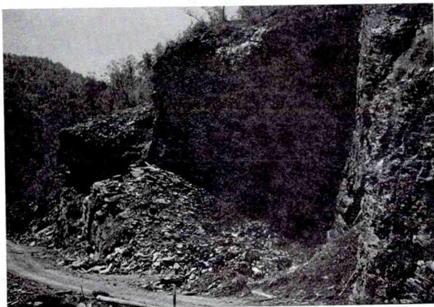
Bildet viser veien med en del av bruddet.
