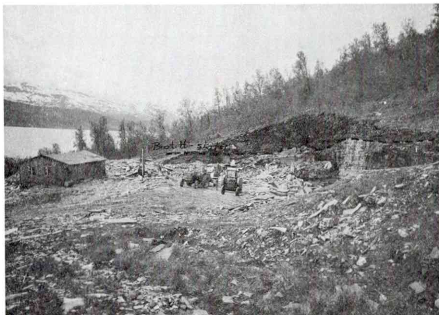
Fig. 17. Brudd nr. 8 (hovedbruddet) sett i retning NV.
