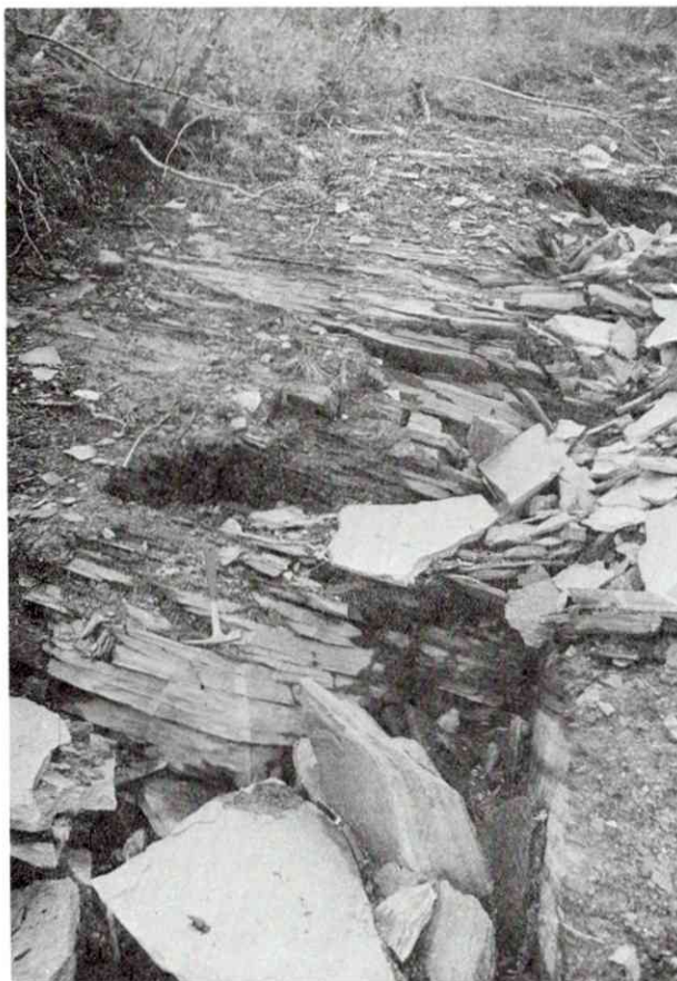
Fig. 10. Skifrig meta-arkose og kvartsglimmerskifer i avrøsket og oppsprengt dreneringsgrøft ved traktorveien ovenfor gården Nysætre.
