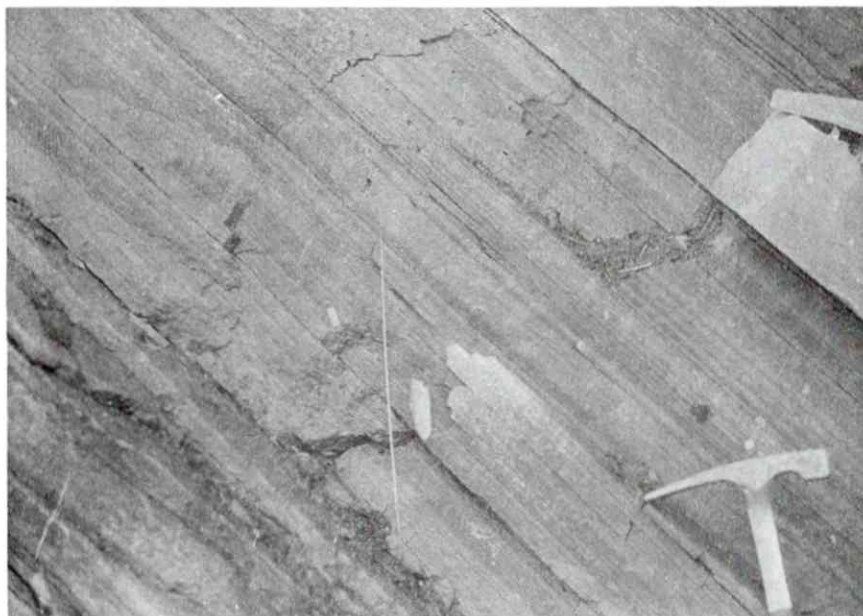
Fig. 6. Prøvebrudd ved enden av traktorvei ovenfor gården Nysætre.
