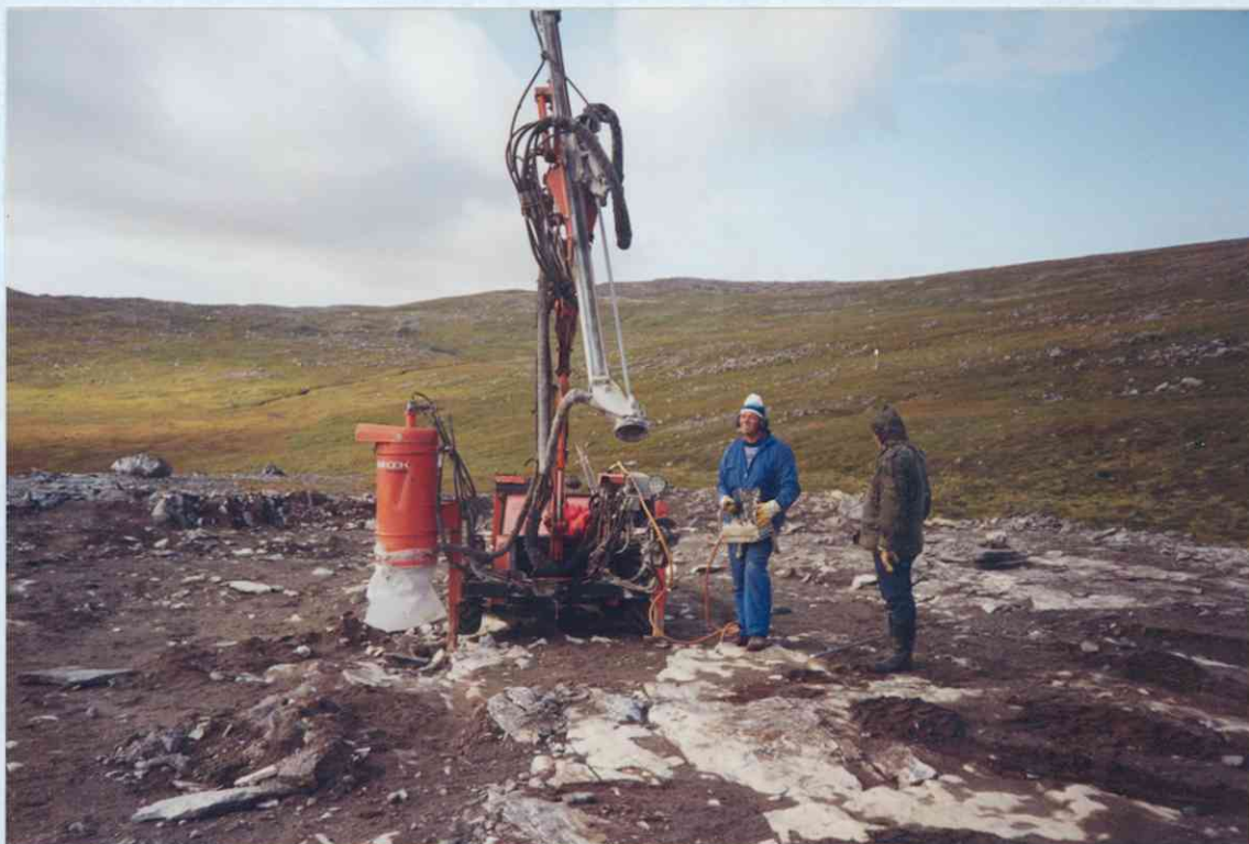
Figur 6. Boring av hullrekker - uttakssted 2. Endel av det avdekkede og spylte område vises også.
