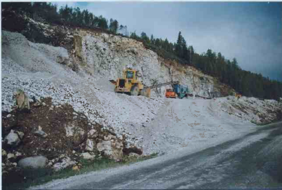
Fig. 2. Pukkverket ved Urda sett mot nord.
