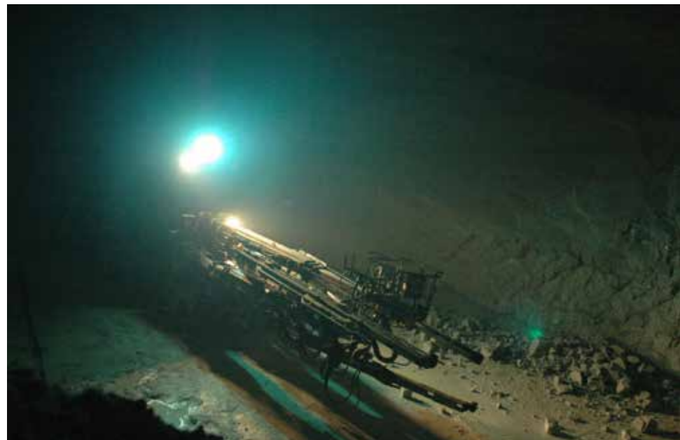
Borerigg i gruva i Hekkelstrand, Ballangen Foto: Agnes Raaness
