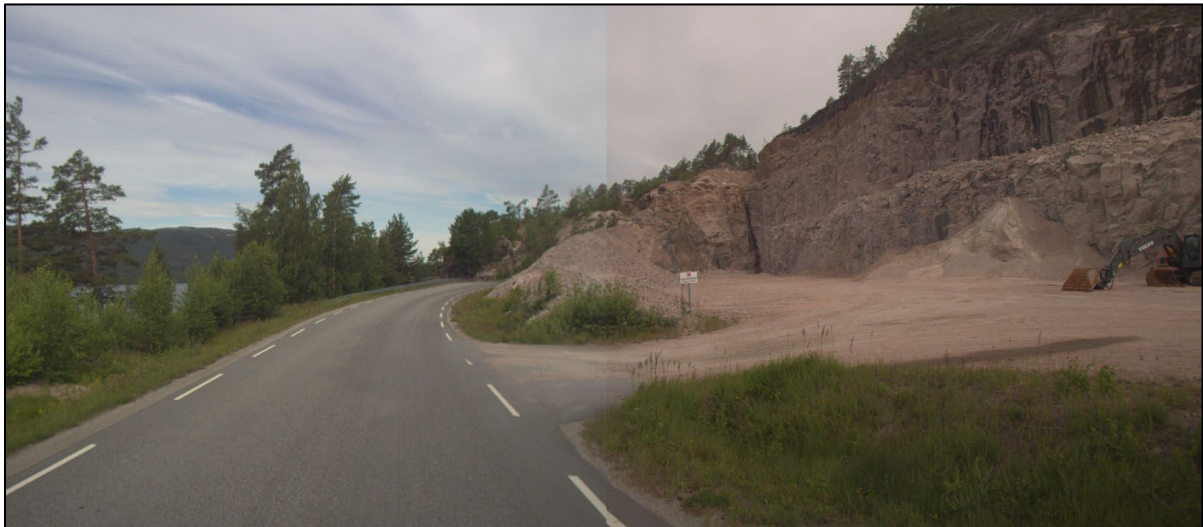
Figur 15: Vegbilder fra Statens vegvesen 03.07.24 viser eksisterende skilt.
